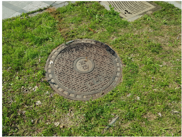
내용 맨홀 뚜껑 상태양호
