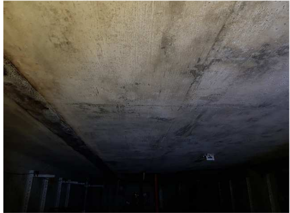
내용 상부슬래브 상태양호
