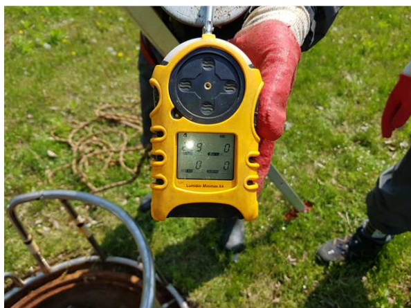
내용 출입전 산소 농도 측정
