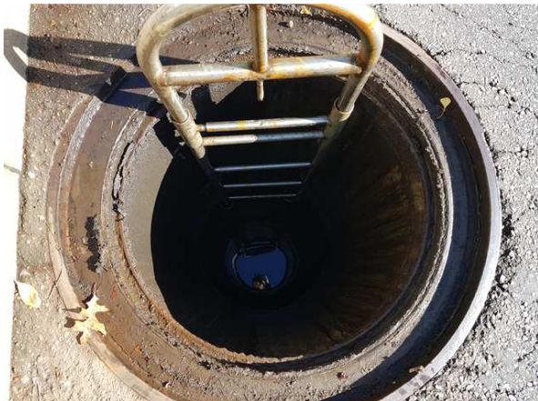
내용 수직구 상태양호
