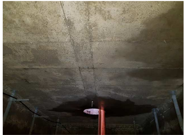
내용 상부 슬래브 상태양호
